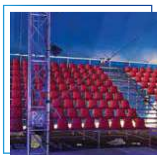
Diseño, fabricación e instalación de estructuras metálicas y graderías Multi-Stark para el Circo De Las Estrellas.
