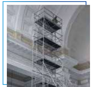
Mantenimiento y pintura de interiores del palacio de justicia.
